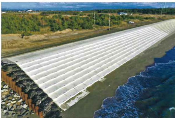
防災林造成事業(海岸防潮堤) 潟上市一向地区
