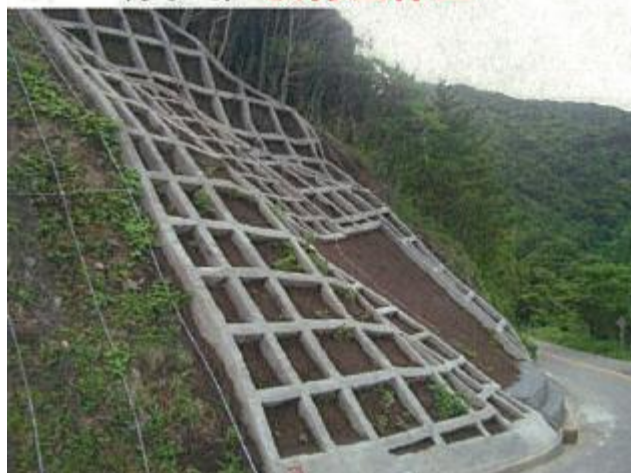
(変更) 吹付法枠工
