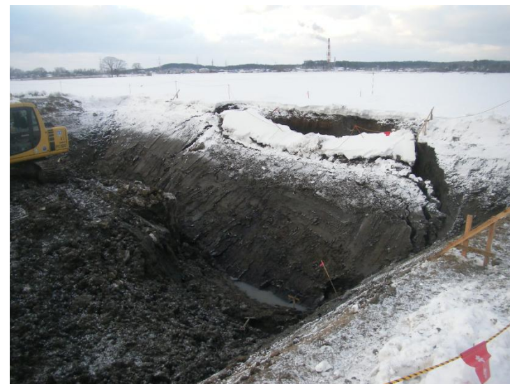
当初設計での掘削状況
